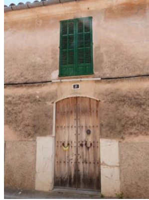
Façana (detall portal)
