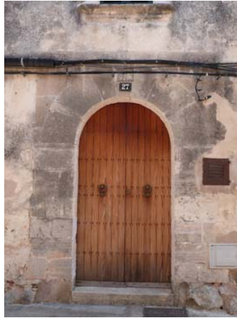
Façana (detall portal)
