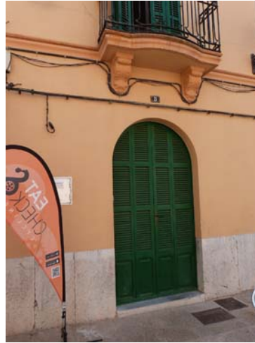
Façana (detall portal)
