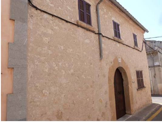
Façana carrer des Vent
