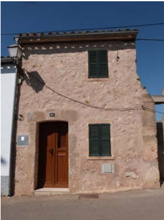
Façana carrer de Son Vent
