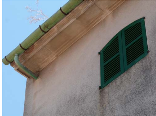
Façana (detall cornisa)
