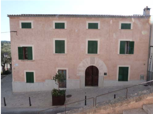
Façana carrer Costa des Pou
