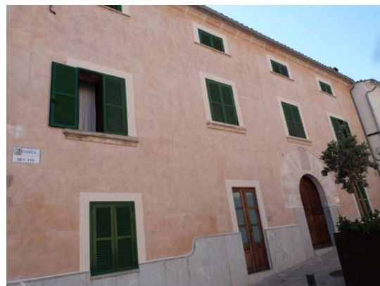
Façana carrer Costa des Pou
