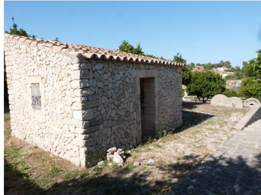
Caseta de nova construcció
