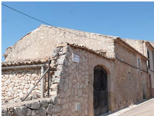
Façana, detall portassa
