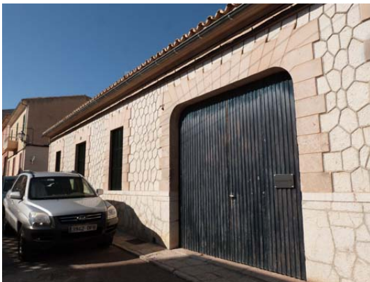
Façana, detall portassa
