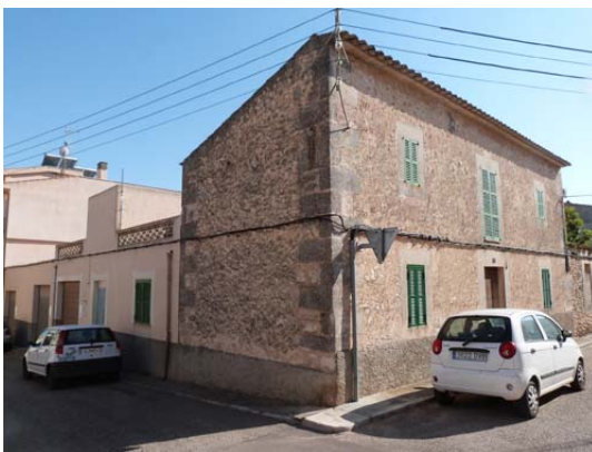
Façana carrer Senyora de Manresa
