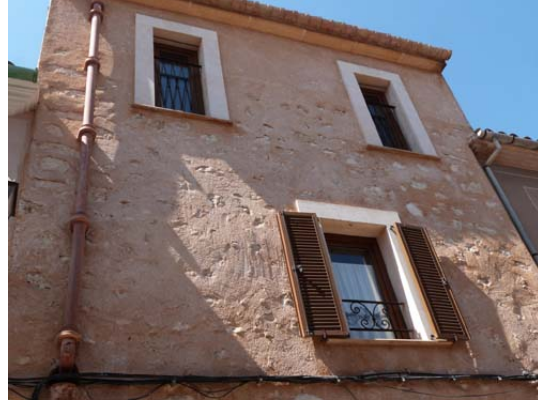
Façana (detall obertures P1-P2)
