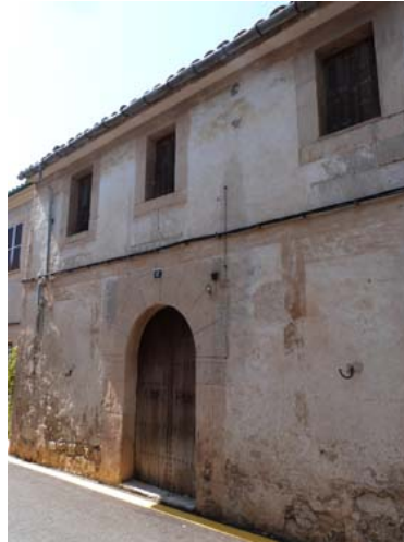
Façana, detall portal
