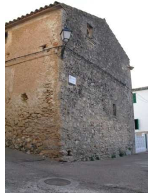
Façana carrer sa Riba
