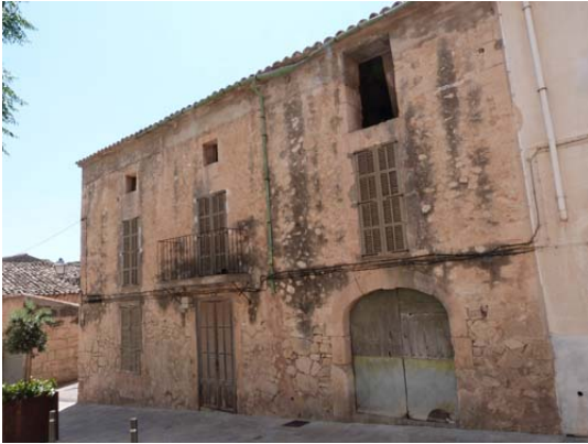
Façana (carrer costa des Pou)
