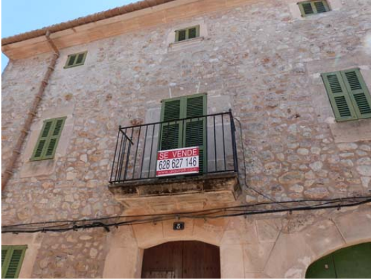
Façana (detall P1 i porxo)
