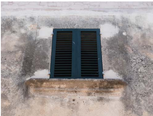
Façana (detall finestra)
