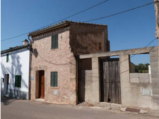
Façana carrer de Son Vent
