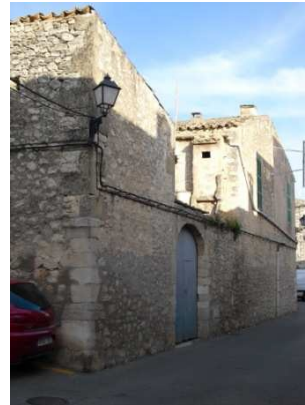
Façana carrer des Vent
