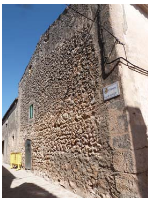
Façana carrer Sant Josep
