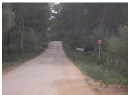
Des de la intersecció del Terme de Sencelles
