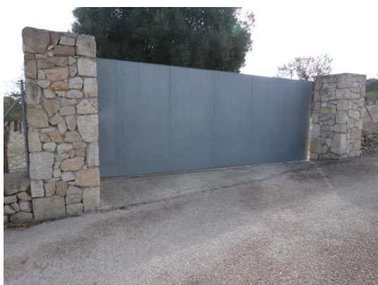
Barrera a l'inici del tram 2
