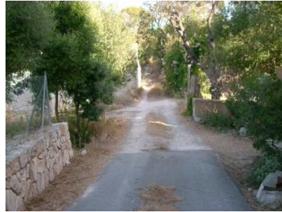
Tram 1. inici tram 2
