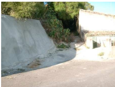
Tram 2. Intersecció camí Son Fred
