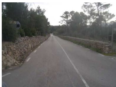
Intersecció amb carretera Ma-3141
