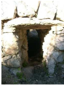
P12 Pont de la síquia Comes de Can Fred
